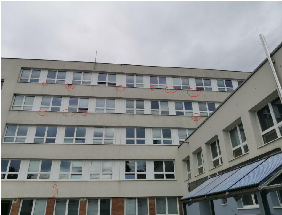
Místa zatékání pod parapety, znečištění omítky nad okny a pod oplechováním atiky na fasádě dvorní části budovy
