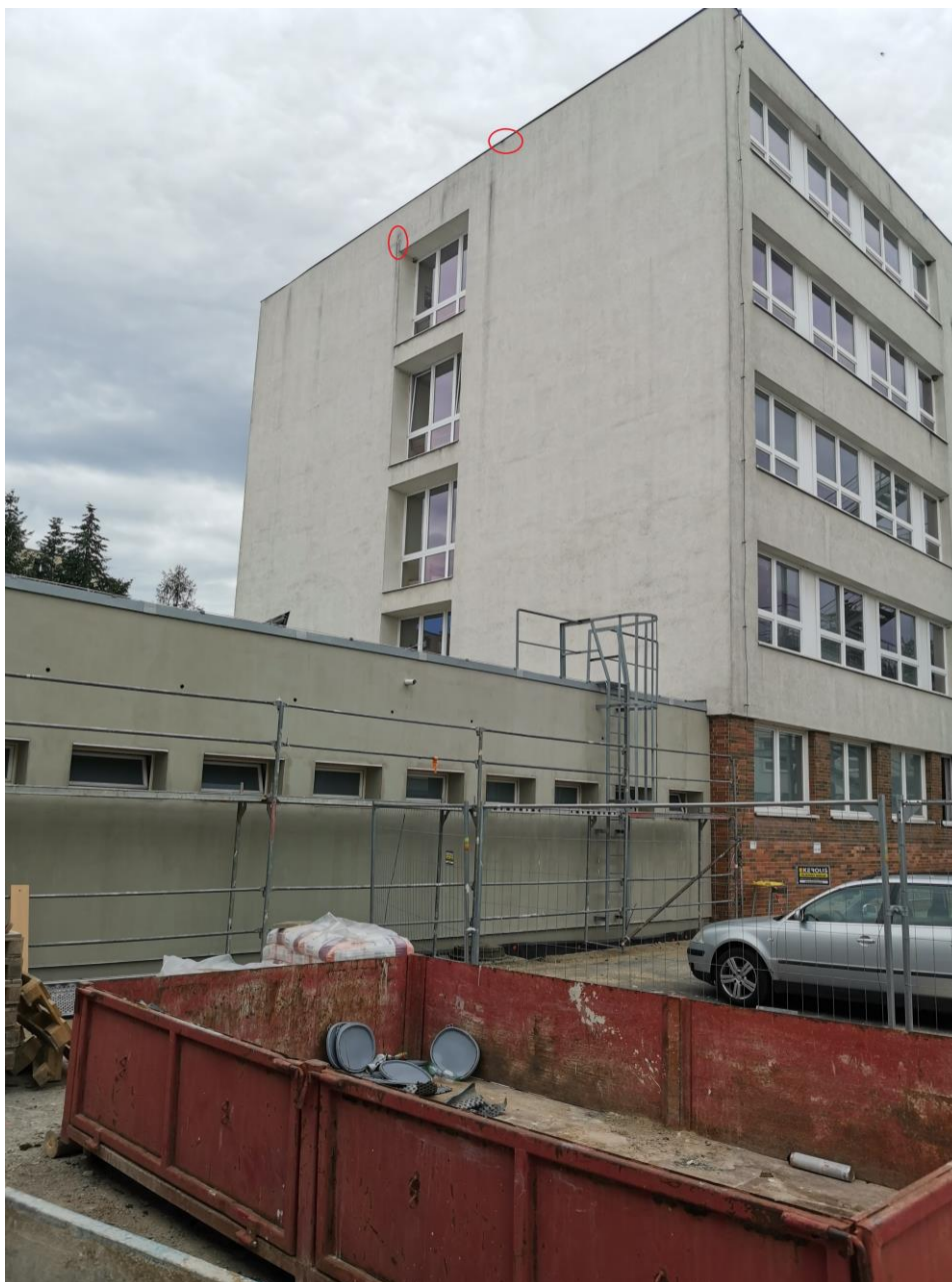
Místa znečištění omítky nad okny a pod oplechováním atiky z boční na fasádě boční části budovy
