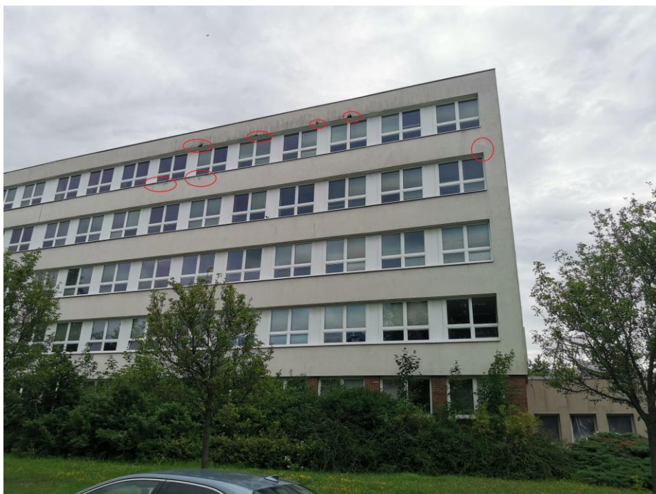
Místa zatékání pod parapety, znečištění omítky nad okny a pod oplechováním atiky na fasádě vstupní části budovy
