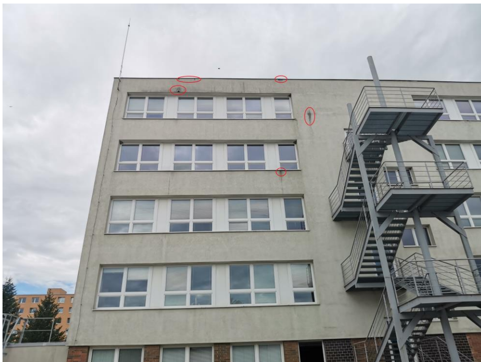
Místa zatékání pod parapety, znečištění omítky nad okny a pod oplechováním atiky na fasádě dvorní části budovy
